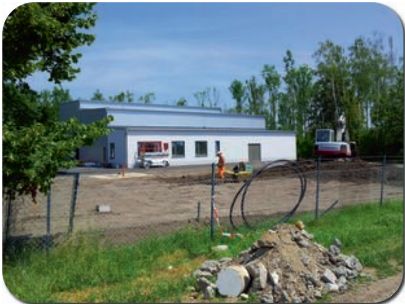
Baufortschritt der Naturfilteranlage für die Trinkwasserversorgung.
