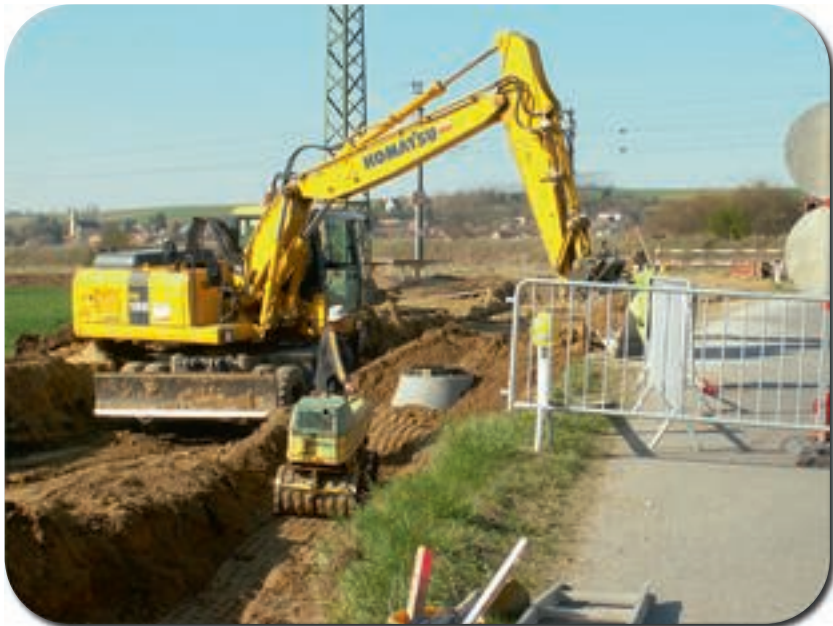
... Drösing und Anschluss an das Kanalsystem.
