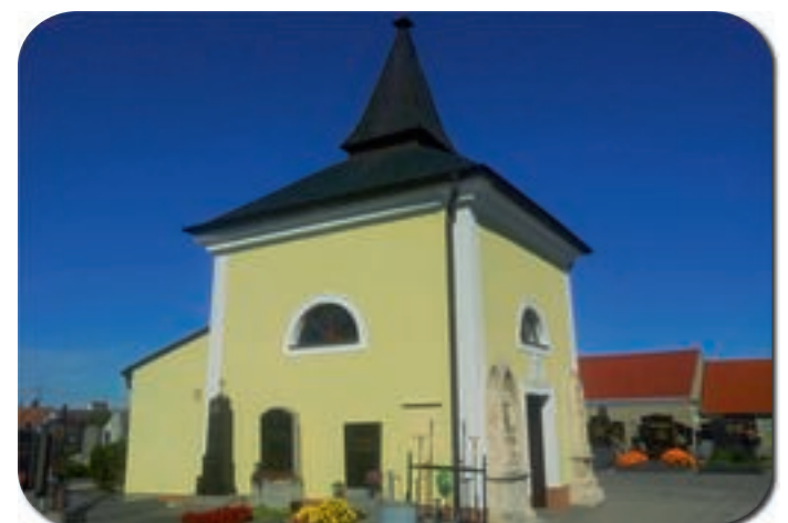
- 10 - Generalsanierung der Friedhofskapelle in Drösing
