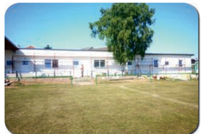
Neue Fassade für den Radrastplatz
