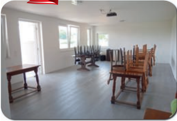
Innenausbau und neue Fassade für ...
