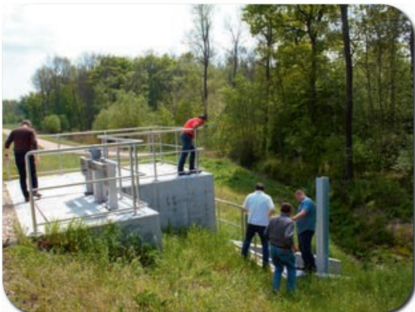
Neue Einbauten und Durchlässe überprüft - der Damm ist fertig!
