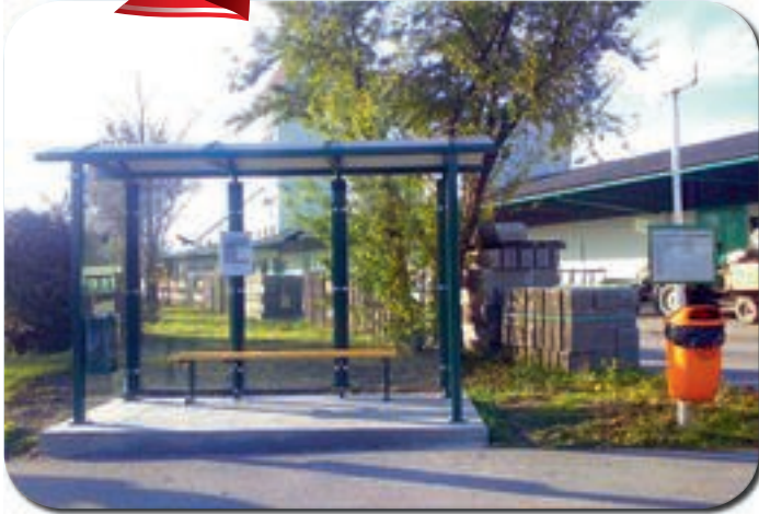
Errichtung Buswartehäuschen beim Bahnhof
