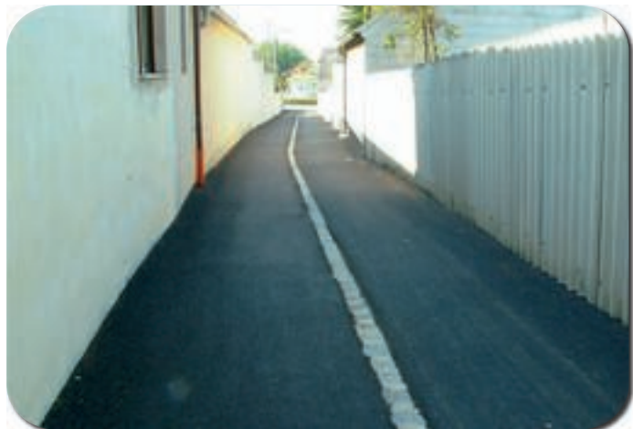
Sanierung Im Gaßl in Drösing
