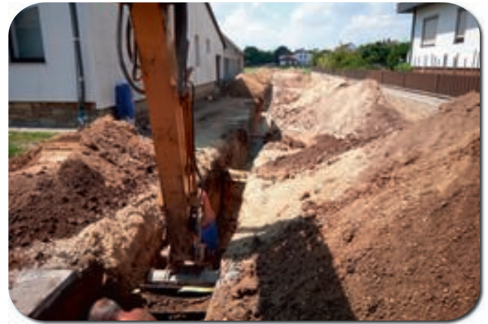
... samt notwendiger Infrastruktur!
