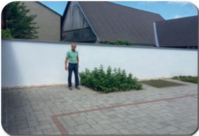
Schulhofmauer komplett erneuert
