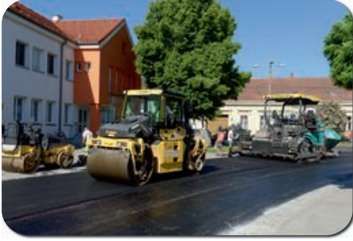
Neuasphaltierung in der Hauptstraße in Drösing ...
