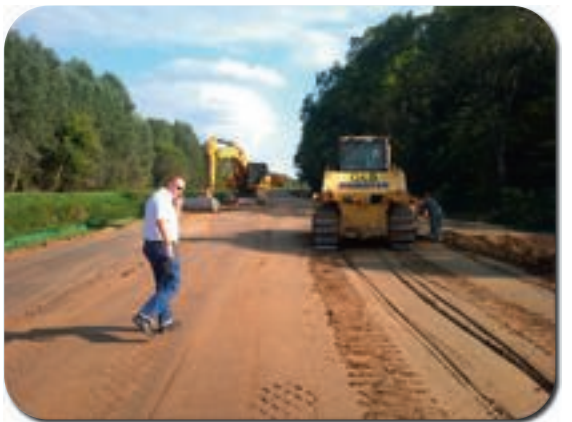
Aufbau des neuen Schutzdammes
