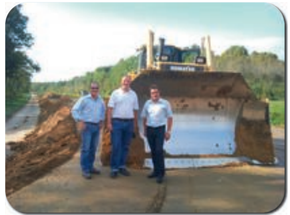
Baubesichtigung am Schutzdamm
