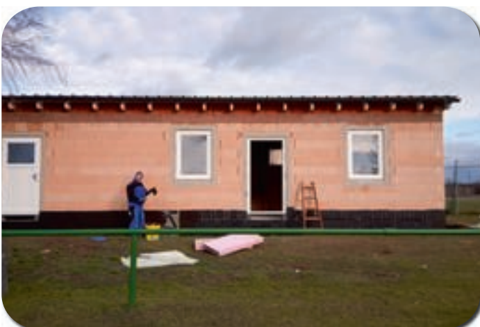
Dacheindeckung und Fenstereinbau
