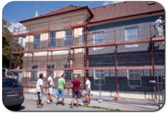
Wärmedämmung - historische Fassade erhalten
