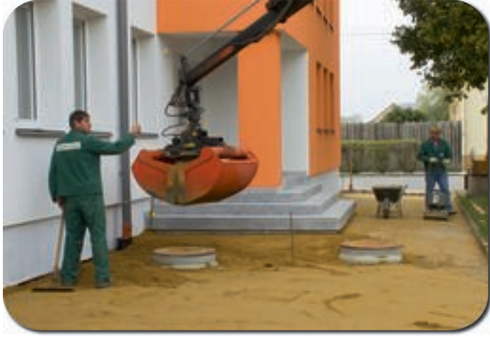
Erneuerung der Stiegen und Vorplatzgestaltung
