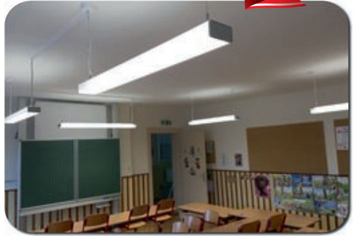
Elektrische Anlage erneuert - LED-Beleuchtung
