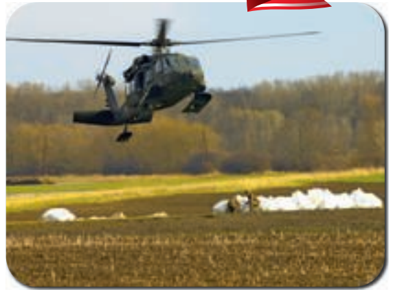
Hubschraubereinsatz am Damm
