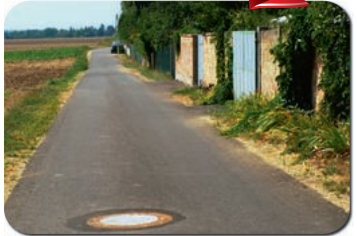
Asphaltierung Hintausweg in Waltersdorf
