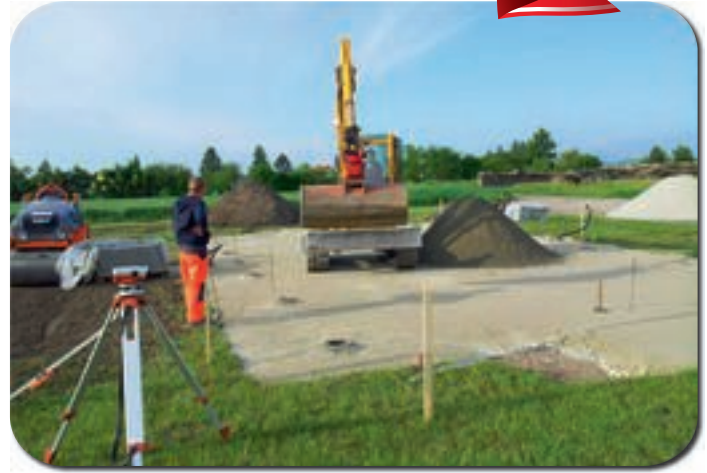
Neubau einer Street-Soccer-Anlage
