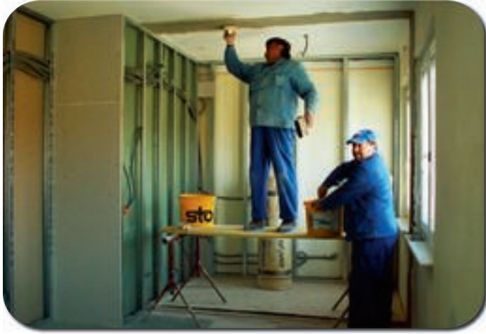
Einbau von 5 Gemeindewohnungen
