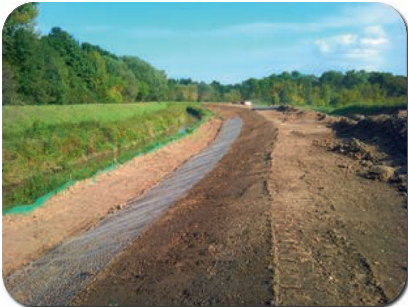
Neubau des Marchschutzdammes - Einbau von Biberschutzgittern
