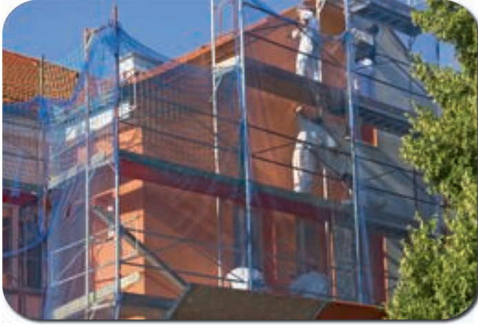
Neue Wärmeschutzfassade
