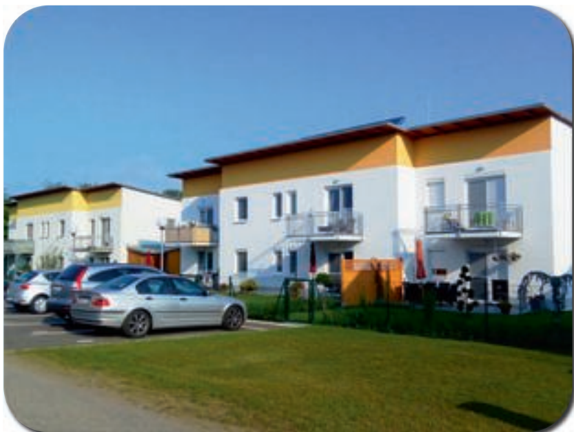
12 neue Genossenschaftswohnungen in der Weidengasse
