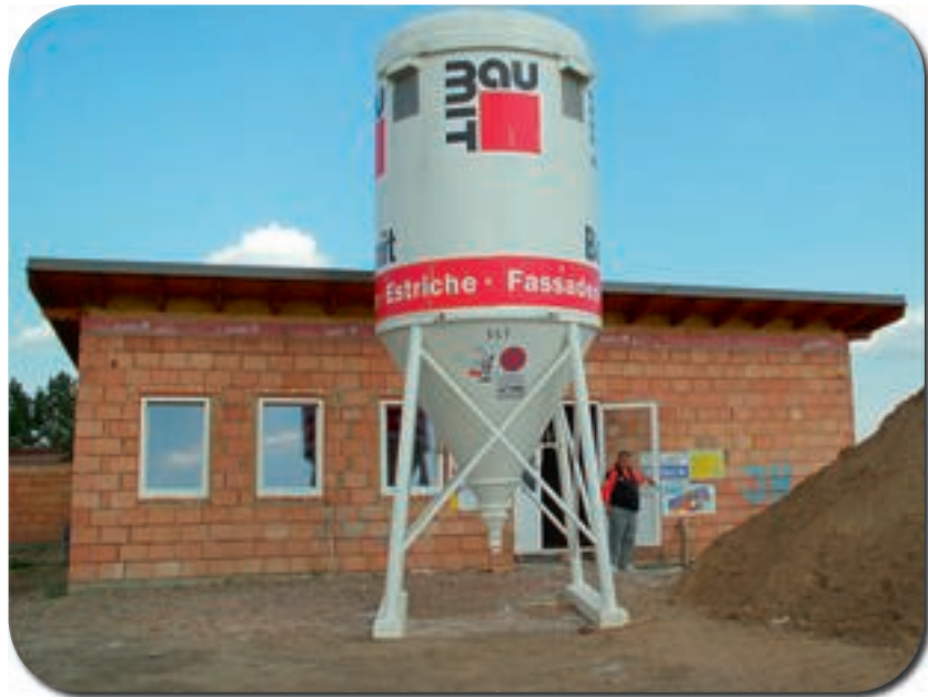
Rohbau des JSFZ Drösing
