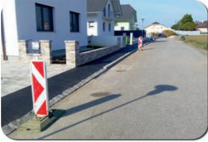
Neuer Gehsteig in der Florianistraße in Drösing
