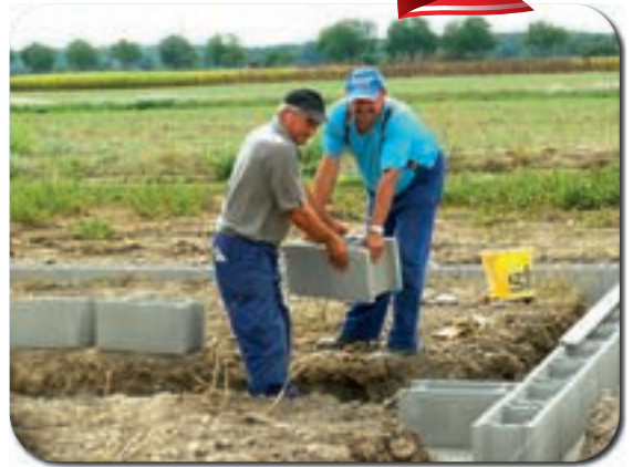
Baubeginn des Jugendzentrums
