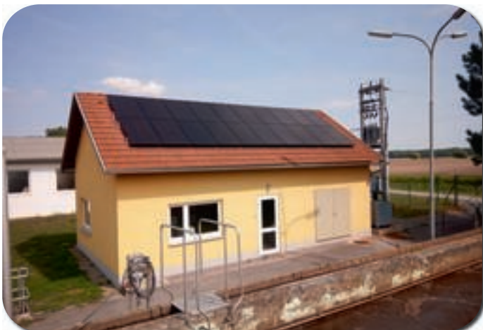
Fotovoltaikanlage für Kläranlage
