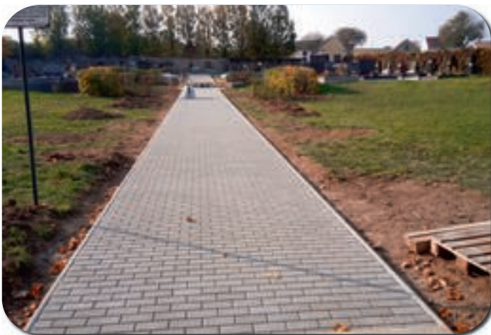
... komplett erneuert und gepflastert ...
