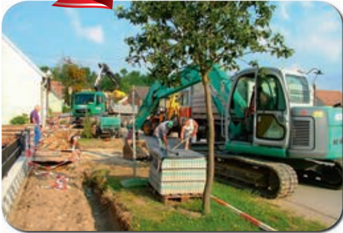
Neuerrichtung Gehsteig Waldgasse in Waltersdorf
