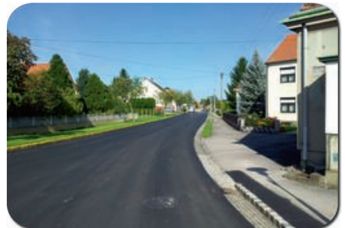
Bahnstraße in Drösing saniert.
