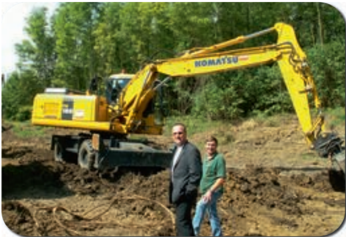
Sanierung der Ausgleichsbecken ...
