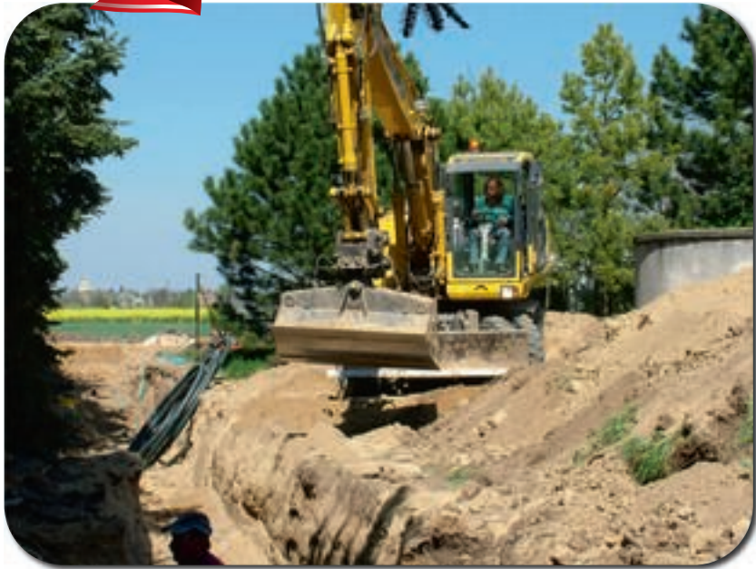
Baubeginn Kanal- und Kläranlagenprojekt 2007
