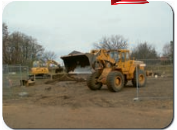
Baubeginn in der Weidengasse
