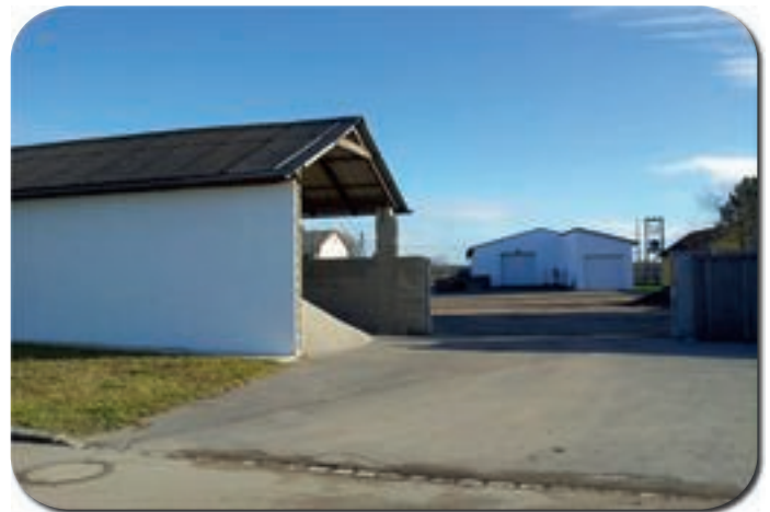
Splitbox mit neuer Fassade
