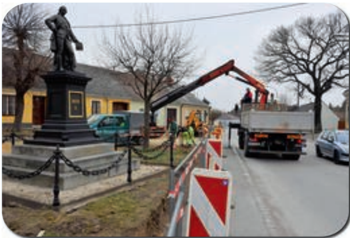
Errichtung von Parkplätzen und ...
