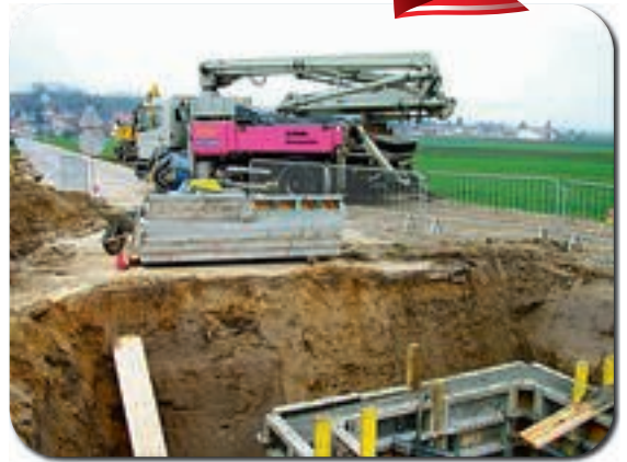
Schachtneubau in der Waldgasse
