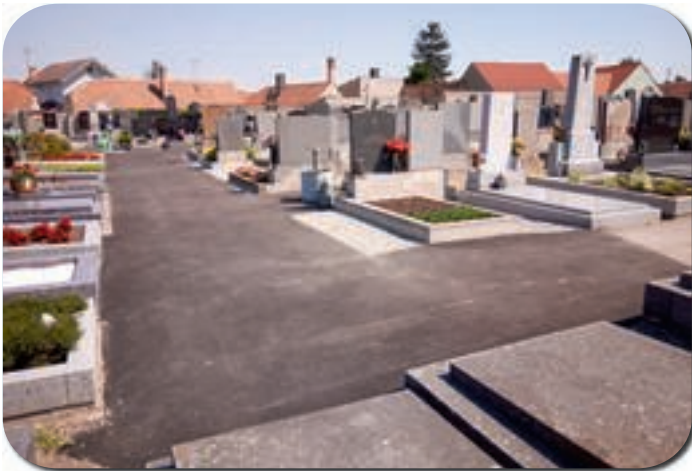
Friedhofweg in Drösing saniert
