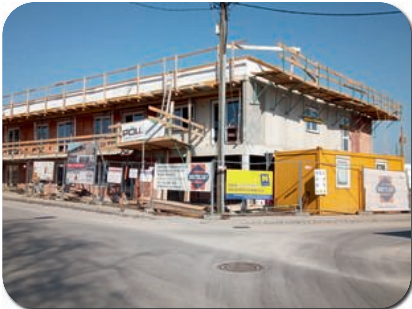
Rohbau mit Fenster
