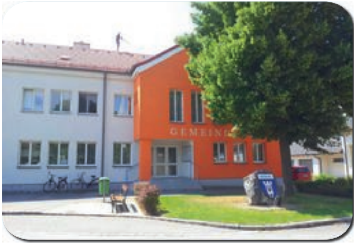
Unser Gemeindeamt nach der Sanierung
