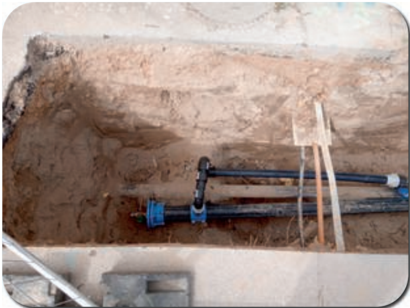
Laufende Sanierungen der Ortswasserleitung
