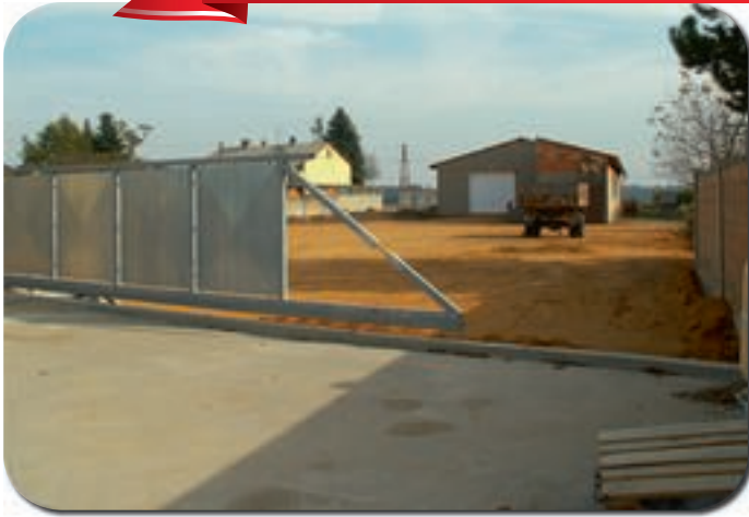
Neue Tore am Bauhof
