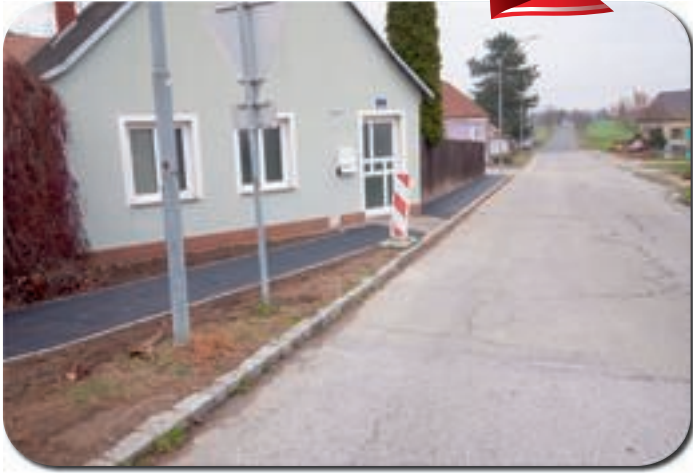
Neuer Gehsteig in Waltersdorf
