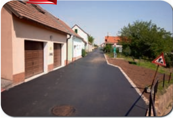
Komplettsanierung der Kellergasse in Waltersdorf
