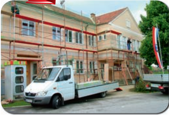
Baubeginn Generalsanierung des Gemeindeamts
