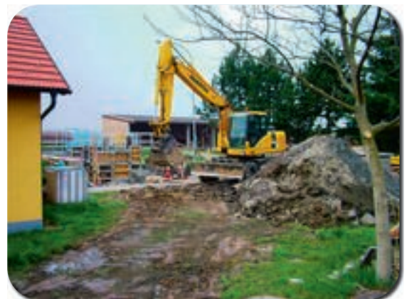
Der Umbau der Kläranlage Drösing ...
