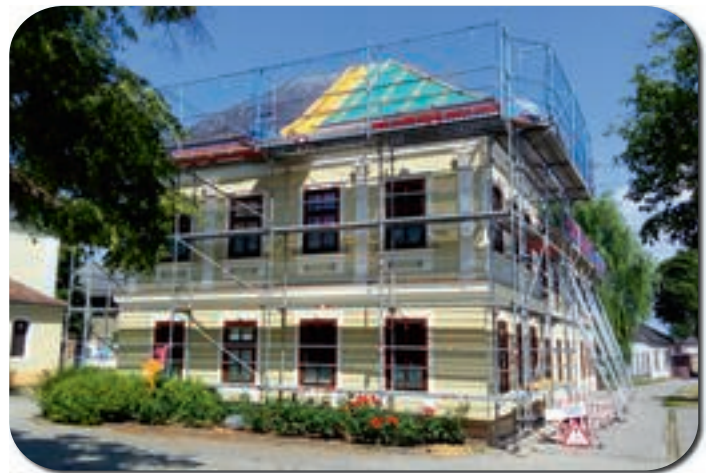
Dachstuhl und Dach erneuert und gedämmt
