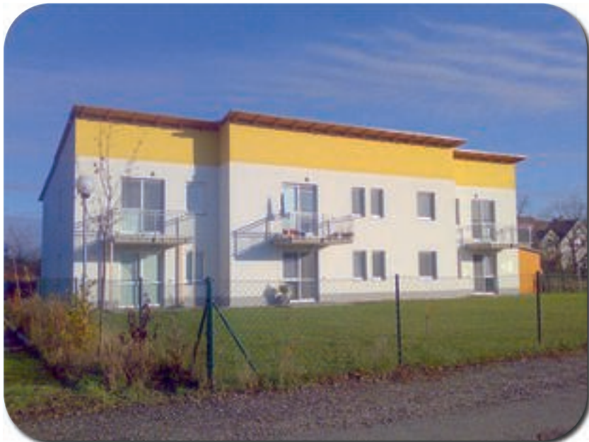
6 neue Genossenschaftswohnungen in der Weidengasse
